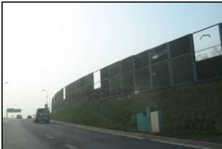
Fot. 9. Przykład kombinacji ekranu ziemnego z ekranem akustycznym (droga krajowa nr 4 na odcinku Kraków - Tarnów)
