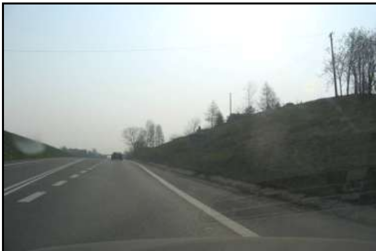
Fot. 1. Wykorzystanie ekranujących własności wykopu (droga krajowa nr 4 na odcinku Kraków - Tarnów)
