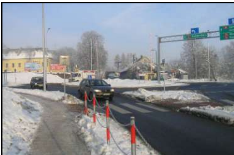
Fot. 6. Przykład ograniczenia prędkości i jednoczesnego utrzymania płynności ruchu poprzez zastosowanie ronda (droga krajowa nr 52 - Wadowice)
