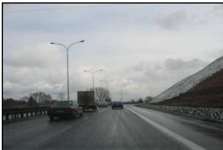
Fot. 8. Przykład wału ziemnego chroniącego zabudowę przed oddziaływaniem hałasu (odcinek drogi krajowej nr 4 Kraków - Tarnów)
