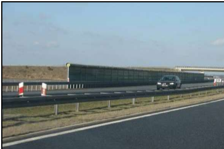
Fot. 7. Przykład typowego zastosowania ekranu akustycznego na autostradzie A4
