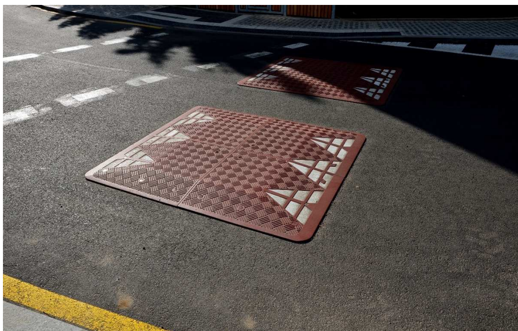
Rysunek 2.3-2 Próg zwalniający o szerokości zapewniającej płynny ruch autobusów komunikacji miejskiej.
